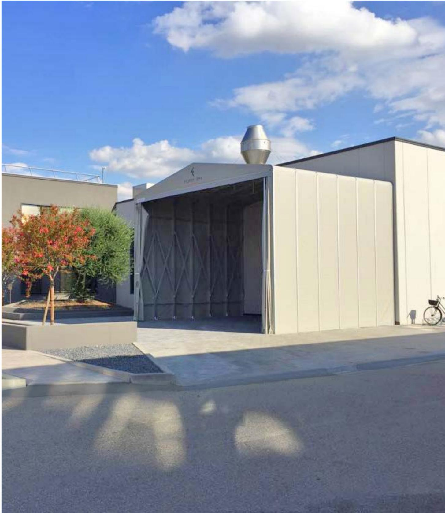
I tunnel retrattili Ready Box, supportati con un giusto sistema di ancoraggio e applicando tensori ad ogni arcata, offrono una sorprendente resistenza al vento, sostenendo fino a 100 Km/h nelle loro varianti più estese. Le azioni variabili di progetto indotte dal vento e dalla neve sono conformi a quanto prescritto dalle norme in vigore che riguardano le strutture temporanee.
